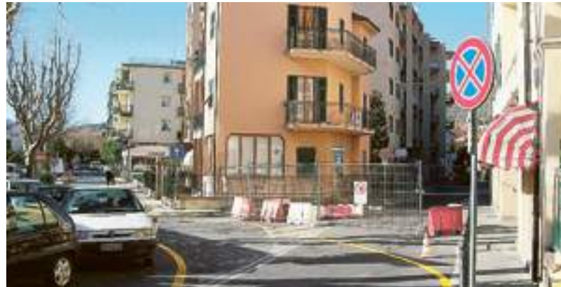
Il cantiere di via Matteotti a Borgio
