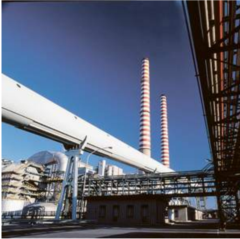
La Centrale Tirreno Power di Vado
